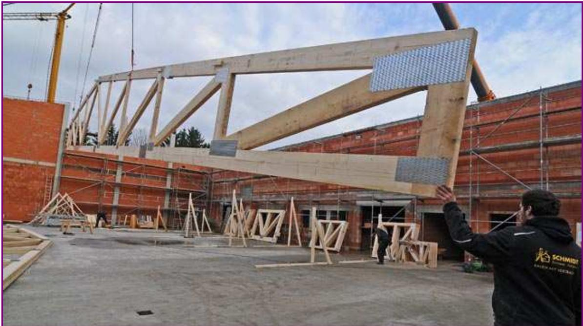
28 Meter lang, eine Tonne schwer, mit einer Hand am Haken dirigiert: einer der Holzbinden für die Turnhallendecke. Fotos: aep
