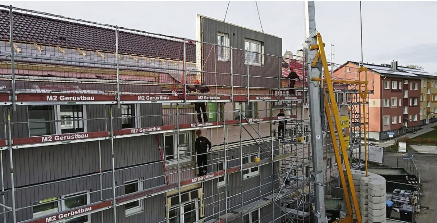
Die Montage der vorproduzierten tonnenschweren Wandelemente an den BSG-Gebäuden in der Curtmannstraße hatte vergangene Woche Montag begonnen, Mitte dieser Woche waren diese Arbeiten bereits beendet. SCHMIDT HAUSBAU
